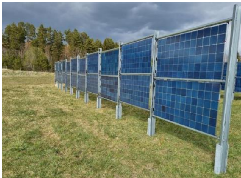
Figure 1 Vertical AV system at Kärro Prästgård.
