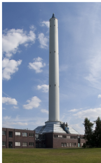
Abbildung 3: Der 146 Meter hohe Fallturm in Bremen, in dem zur Zeit vorbereitende Experimente zum Äquivalenzprinzip an frei fallenden Quantengasen durchgeführt werden.
